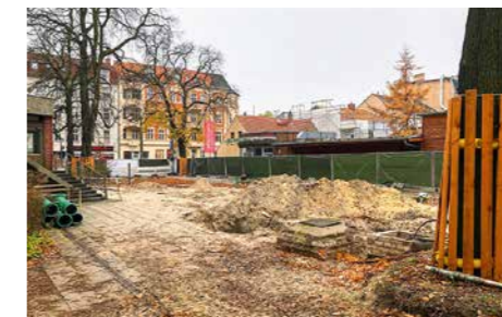
An mehreren Stellen des Geländes muss der Boden aufgebrochen werden
